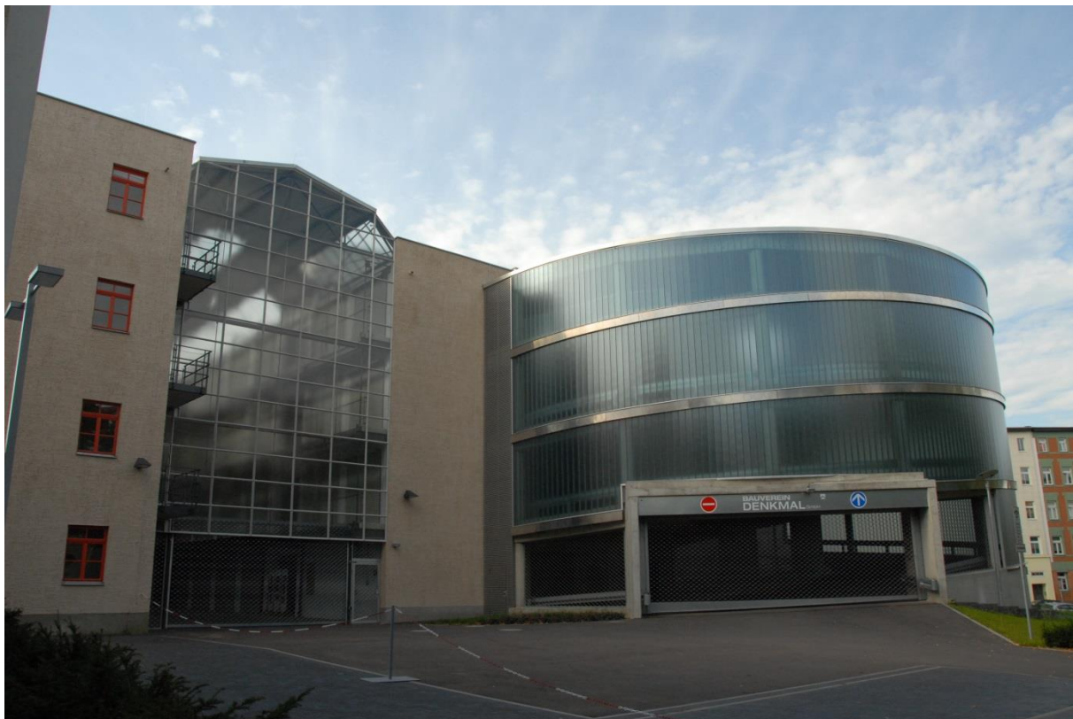
Links der alte Teil, rechts die neu angebaute Spiralzufahrt
