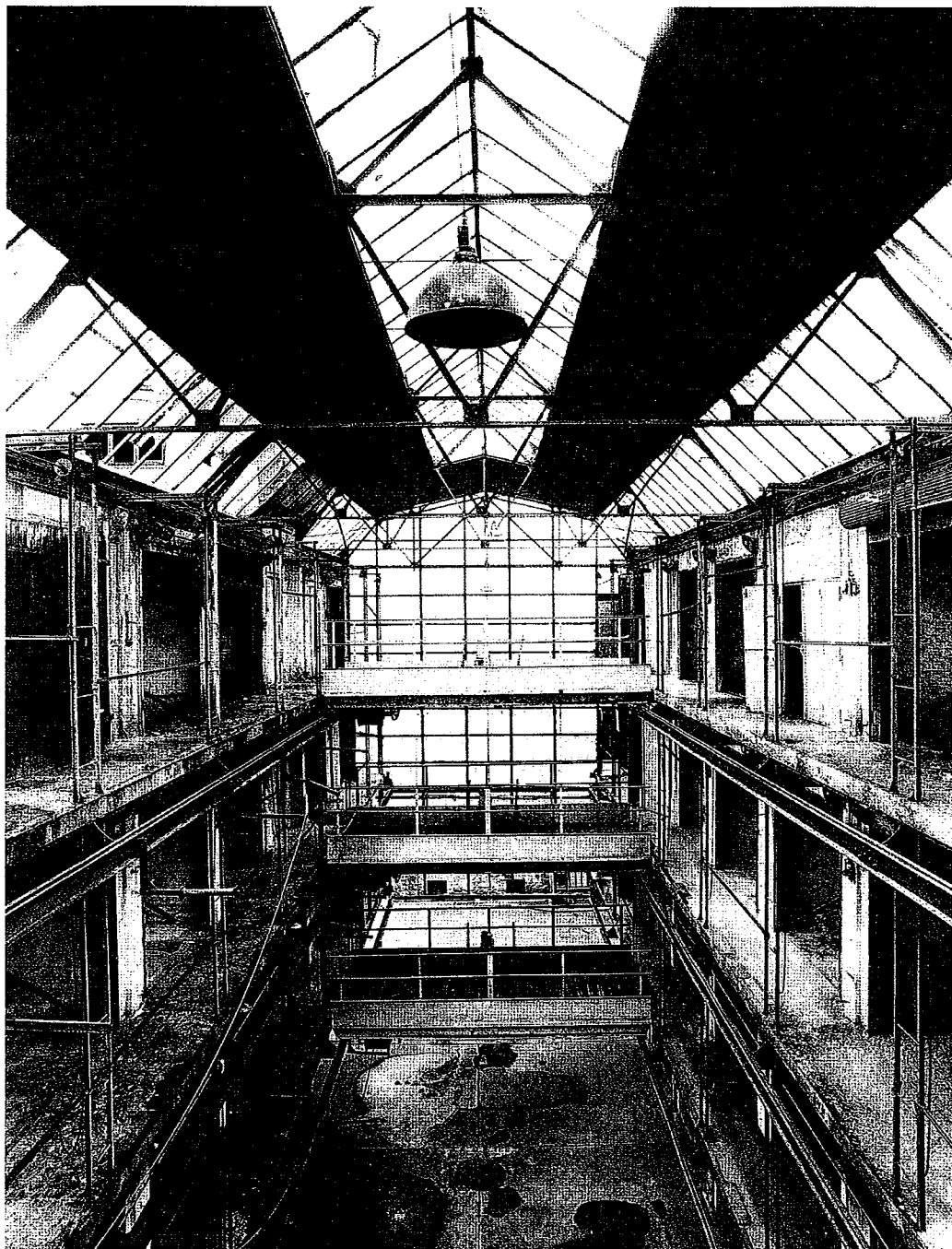
5 Lichthof der Fahrzeughalle mit beiderseitigen Boxengeschossen und Schiebebühnen, 2001
