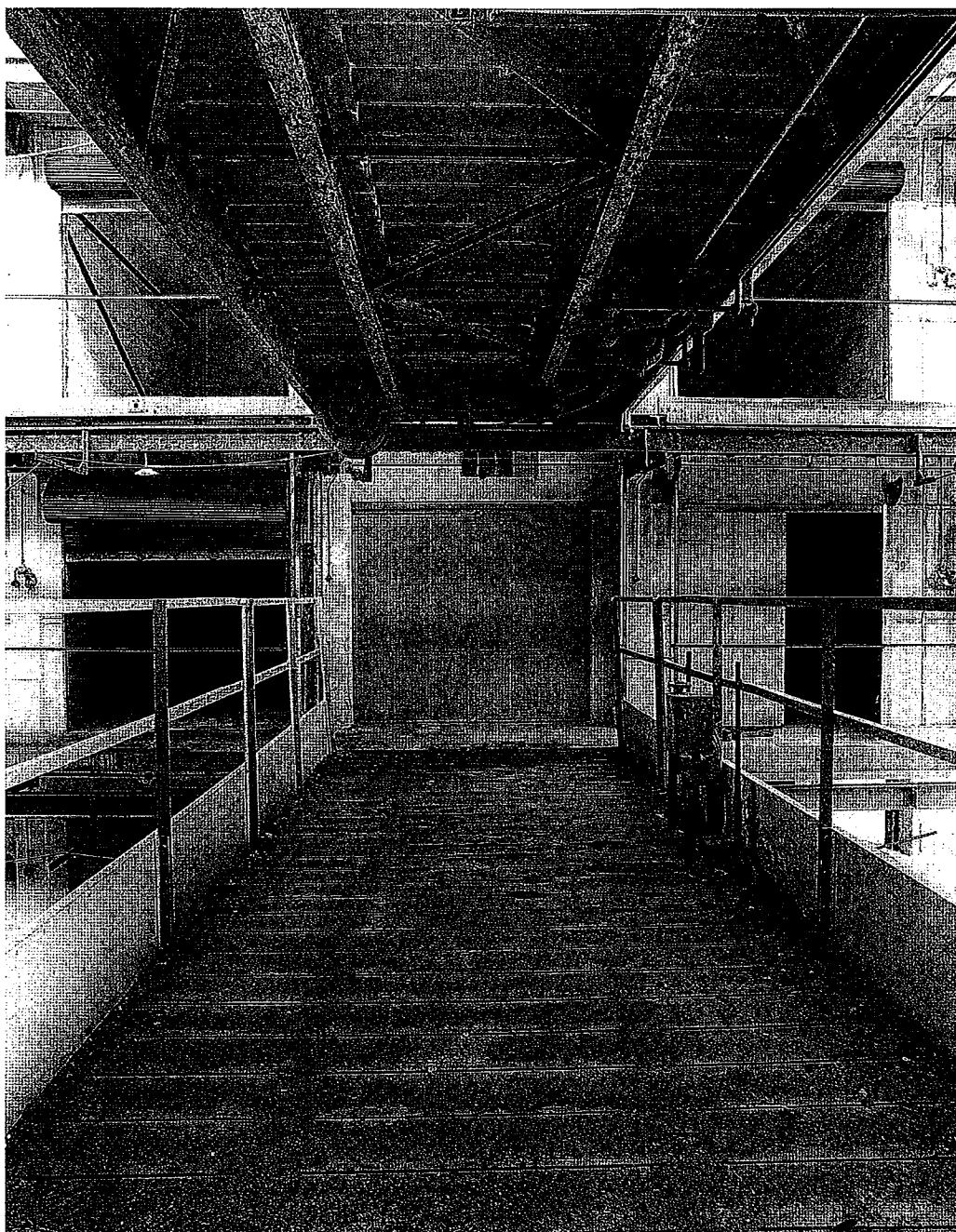
8 Transportfläche der Schiebebühne im ersten Obergeschoss der Fahrzeughalle, 2001
