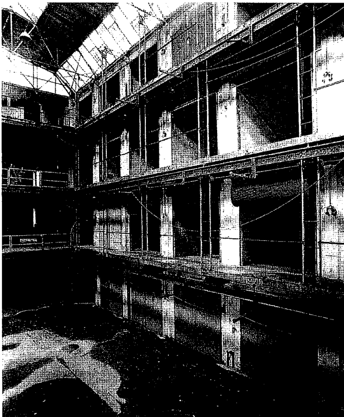
6 Linker Boxenkomplex der Fahrzeughalle, deutlich erkennbar die noch vorhandenen blechernen Rolll Tore, 2001
